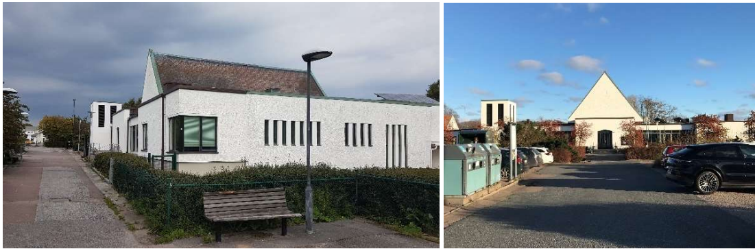
Nässets kyrka, sedd från sydväst och väster.
